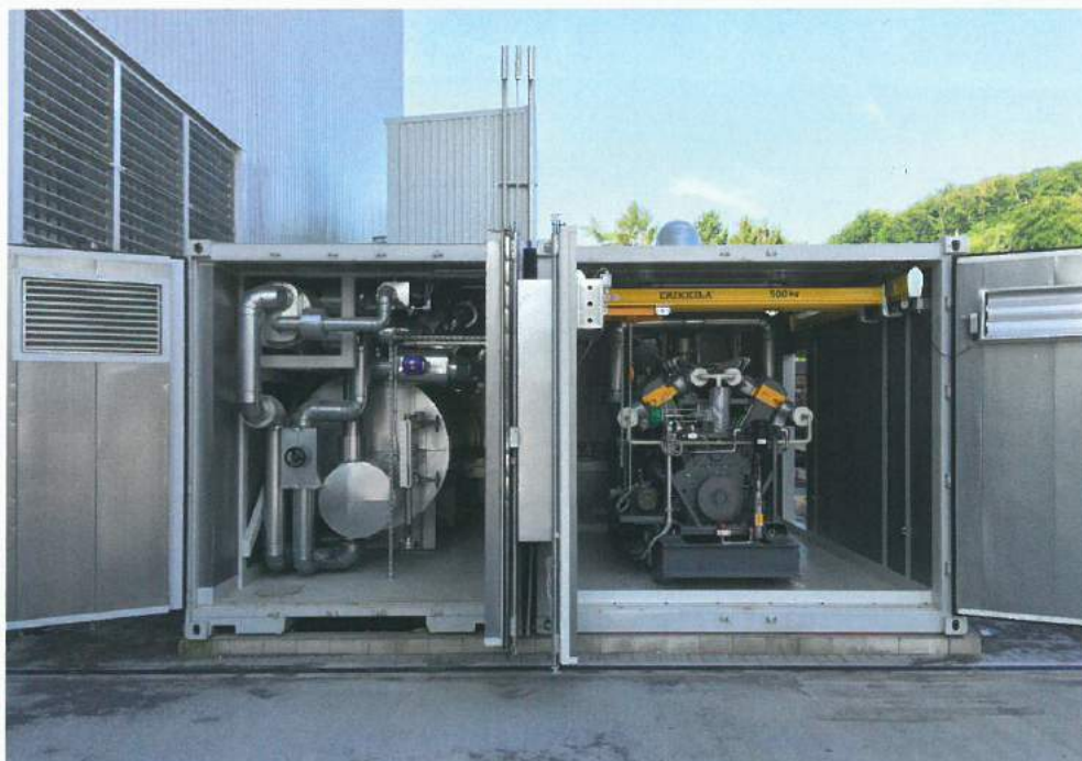
Bild 4: ORC-Modul mit Dampfexpansionsmotor
